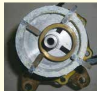
真空ポンプ ベーン固着による 作動不良及び吸水不能
